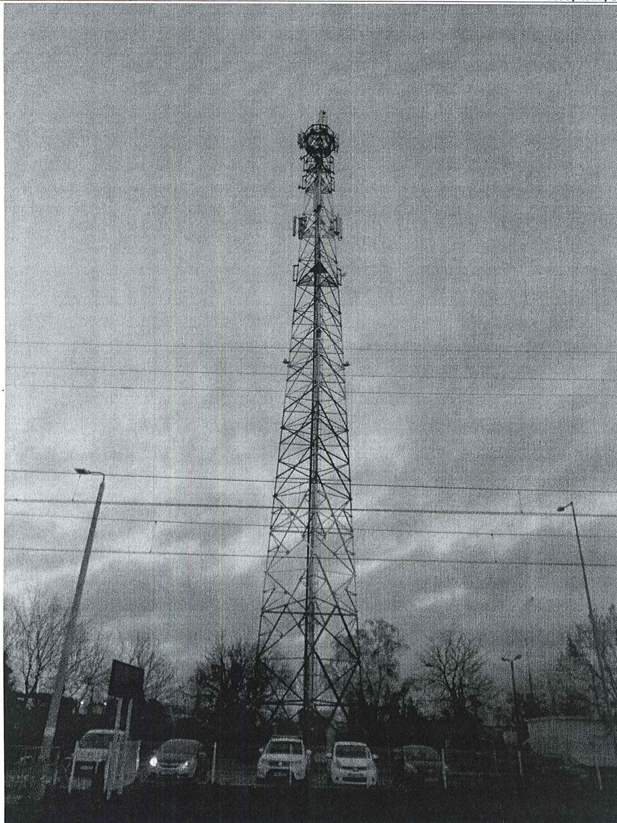
Załącznik nr 3 Instalacja Radiokomunikacyjna T-Mobile Polska S.A. 40399 (64399N!) PPI_OBORNKI_METALPLAST Dokumentacja fotograficzna
